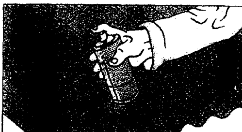
Рис. 14. Окраска срезов, сколов и повреждений защитного слоя
